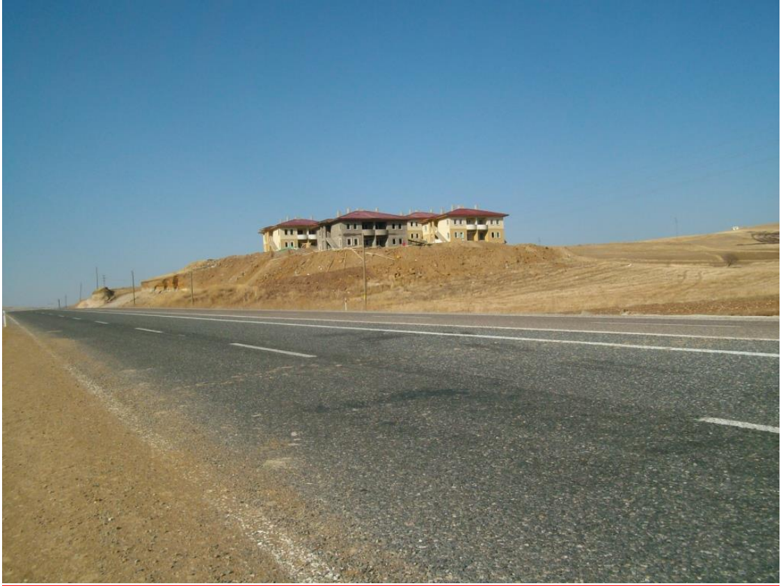
SAĞLIK OCAĞI VE 112 ACİL İSTASYONU İNŞAATI
